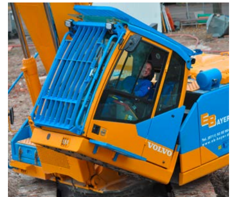
Mauro Pimpinella, der Maschinist des Raupenbagger, freut sich über seinen komfortablen Arbeitsplatz in der kippbaren Kabine.
